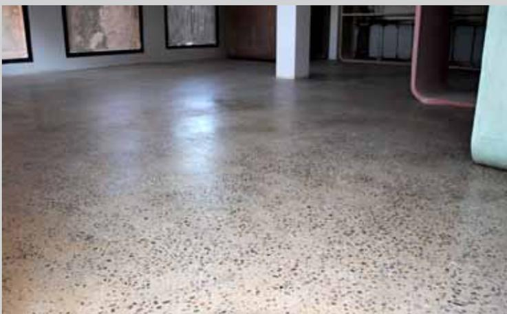
Es un pavimento de hormigón fabricado en central, con una cuidada selección de áridos y reforzado con fibra de vidrio.
