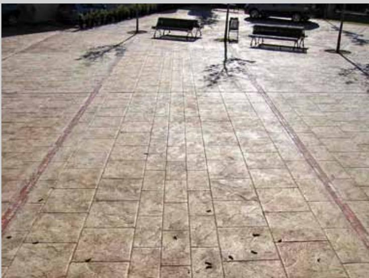
Los pavimentos impresos de hormigón se ejecutan con hormigones frescos fabricados en central, enriquecidos con varios tipos de fibra (polipropileno, vidrio, acero) o mallas reticulares de acero según demanda técnica.
