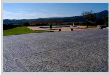
Los pavimentos impresos de hormigón se ejecutan con hormigones frescos fabricados en central, enriquecidos con varios tipos de fibra (polipropileno, vidrio, acero) o mallas reticulares de acero según demanda técnica.
